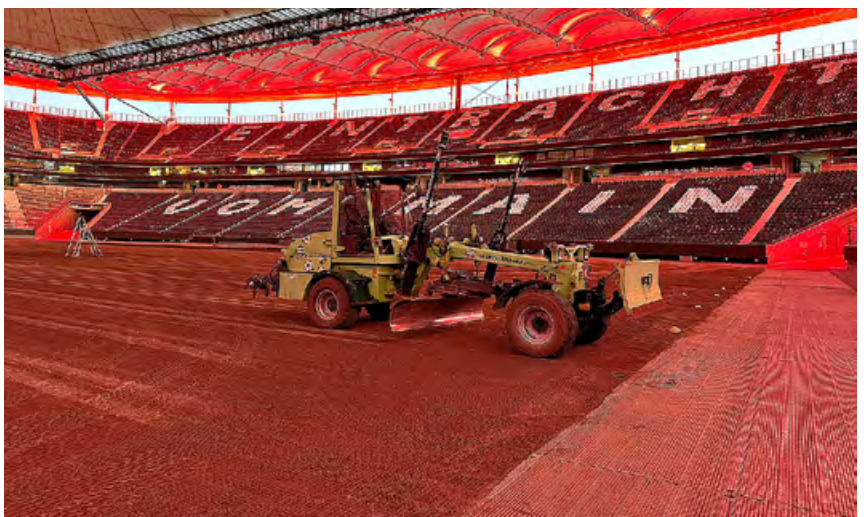
Erd- und Planierarbeiten in der Sommerpause
