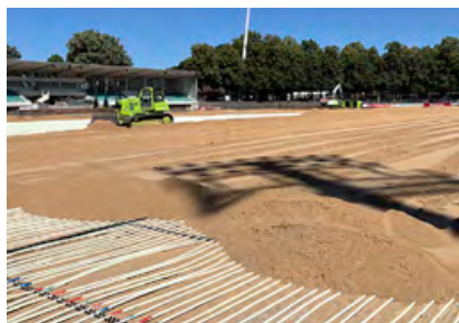
Einbau der Rasenheizung
