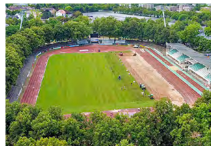
Verlegung des Fertigrollrasens als Dicksode
