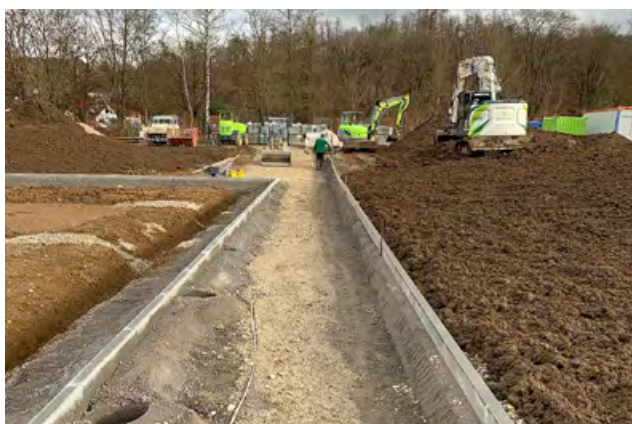
Spielfeld- und Wegeeinfassungen, Fundamentstreifen für Ballfangzäune
