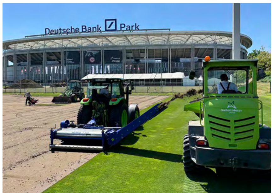
Abfräsen und Entsorgen der oberen Grasnarbe
