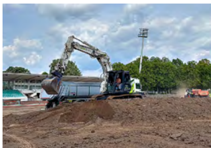
Tragschichtausbau und Bodenstabilisierung
