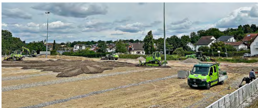
Einbau von Dränagen, Mauerscheiben und DIN-gemäßigem Schichtaufbau
