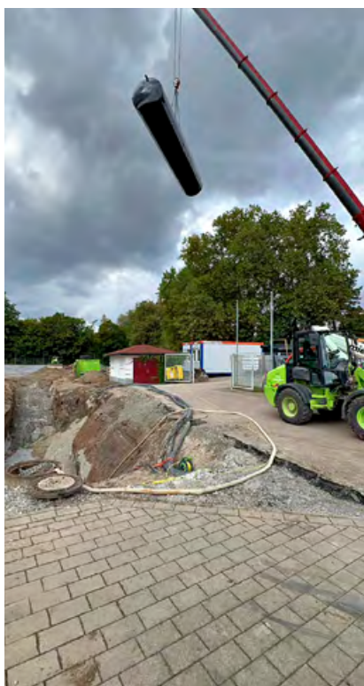
Mehr Nachhaltigkeit: Eine große Zisterne mit Pumpenanlage unterstützt die Beregnung
