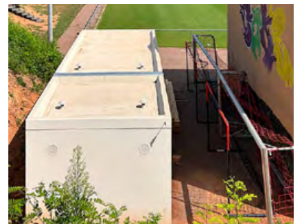
Neue Gerätegarage, dahinter der Technikraum
