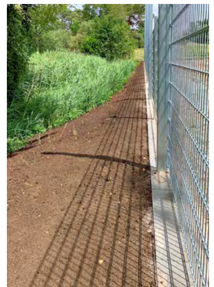
Zaunanlage mit 4 und 6 m Höhe
