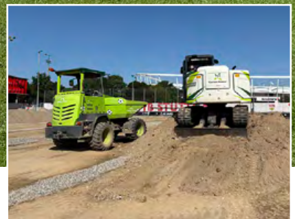
Erdarbeiten für Drainage und Schichtaufbau
