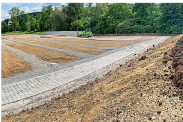
Umfangreiche Geländemodellierungen und neue Drainagen
