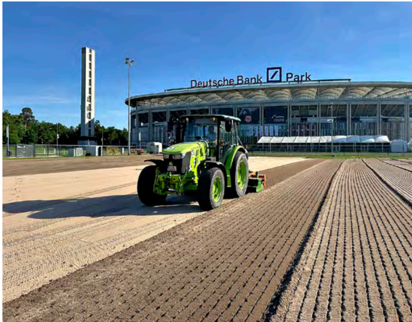
Aufbringen und Einarbeiten von 450 t Sand in die vorhandene Rasentragschicht
