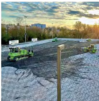
Tragschichtaufbau
