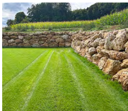
Natursteinmauer gegen Geländeversprung
