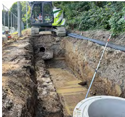
Sanierung eines ganzjährig Regenwasser führenden Kanals unter laufendem Betrieb
