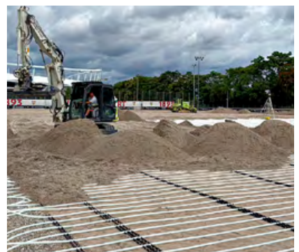
Einbringen der frischen Rasentragschicht
