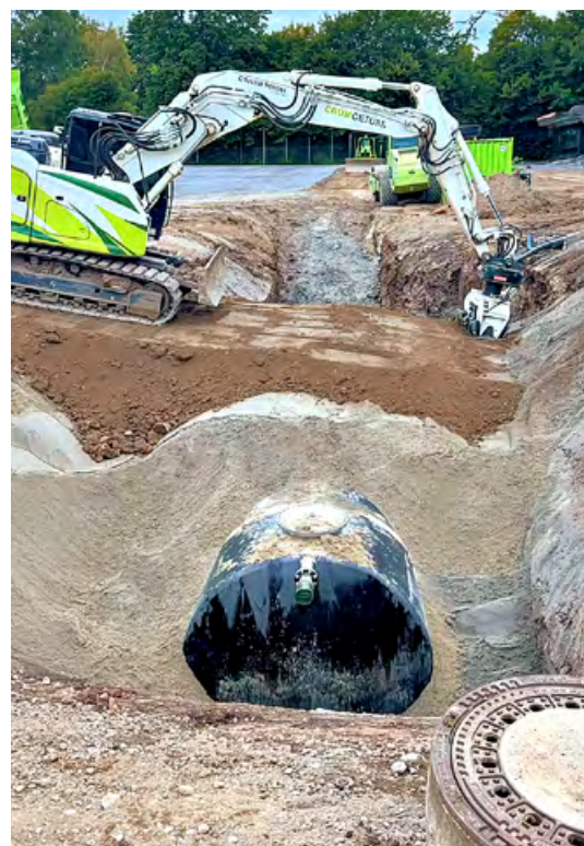
Mehr Nachhaltigkeit: Eine große Zisterne mit Pumpenanlage unterstützt die Beregnung
