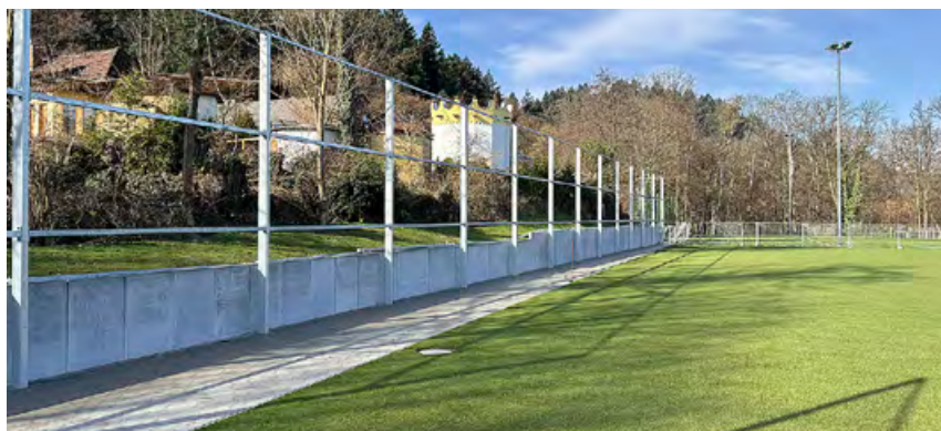
Geländeanschluss mit Verbindungsweg
