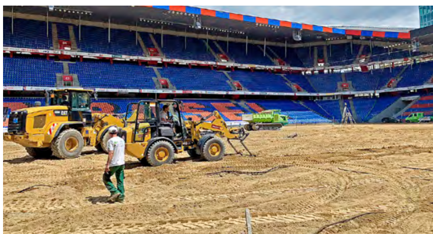
Ausbau der alten Rasenheizung
