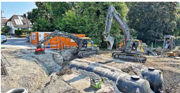
Einbau einer großen Zisterne
