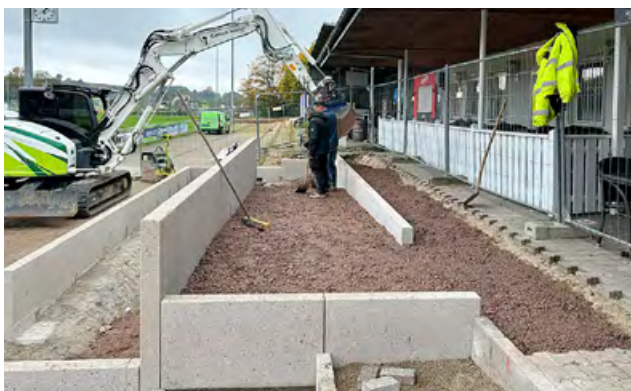
Rollstuhlgeeignete Rampe für barrierefreien Zugang zum Clubheim
