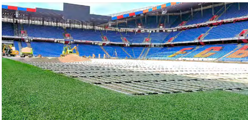
Einbau der neuen Rasenheizung
