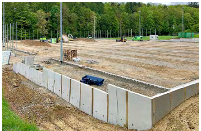
Bis zu 180 cm hohe Mauerscheiben sichern das Gelände
