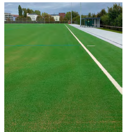
Nachhaltig (II): Kunstrasenbelag mit Sand- und Korkfüllung, Unterstand mit Dachbegrünung
