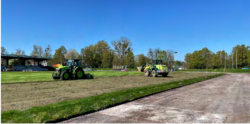
Abfräsen und Entsorgen der organischen Oberschicht, Vorbereiten der Erdarbeiten
