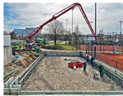
Fundamentarbeiten mit Ortbeton
