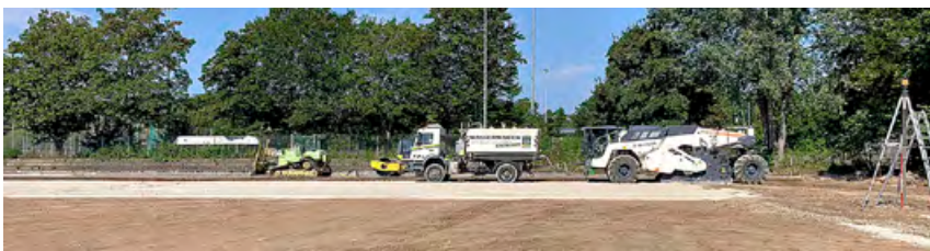
Umfangreiche Bodenverbesserung für mehr Tragkraft
