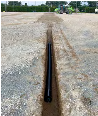
Erneuerung der Dränage
