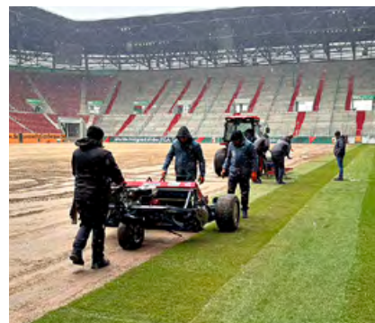
Verlegung der Hybridrasen-Soden bei Schneeregen
