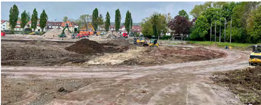
Trennung nach wiederverwertbarem Aushub und unbrauchbarem Material
