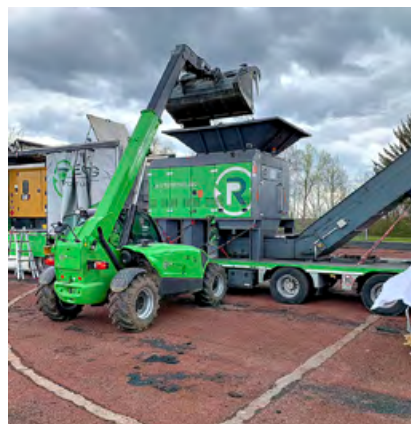
Vor-Ort-Recycling der alten Elastikschicht
