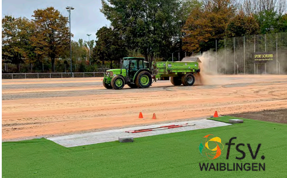
Aufbringen des speziellen Zuschlagstoffes vor der abschließenden Einsaat
