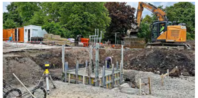
Spezialfundamente für die Flutlichtanlage
