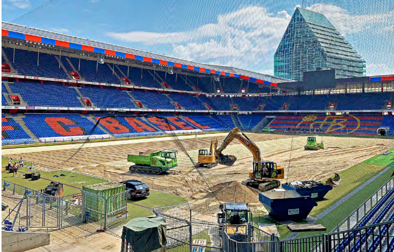
Sanierung auf Hochtouren: Einbringen der neuen Rasentragschicht in der Sommerhitze
