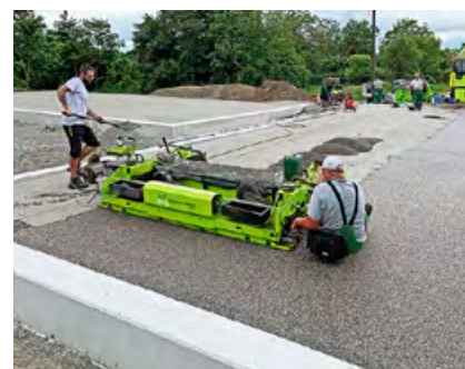
Einbau eines wasserdurchlässigen Spezialunterbaus
