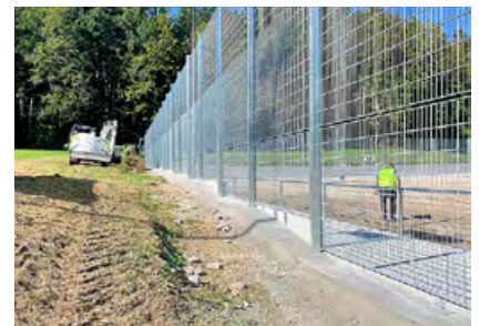
Die Zaunanlagen auf den Mauerscheiben folgen dem Geländeverlauf
