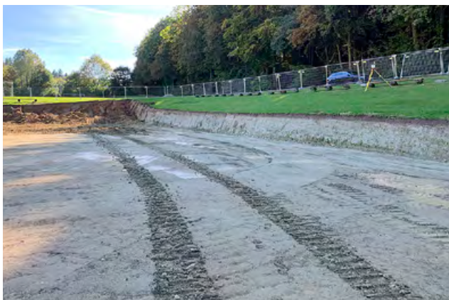
Geländeeinschnitt zur Erweiterung der Spielfeldfläche
