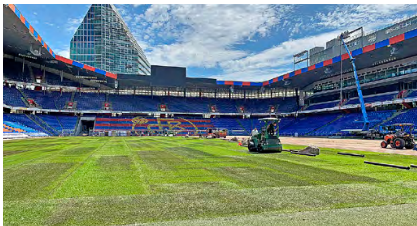
Verlegung des frischen Rollrasens: die etwa 7.500 m 2 Dicksode mit 30 – 40 mm Stärke wurden von 20 Sattelschleppern aus Holland angeliefert.
