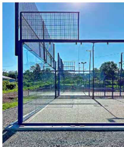
Fertig montierter Court vor Verlegung des Spielbelags
