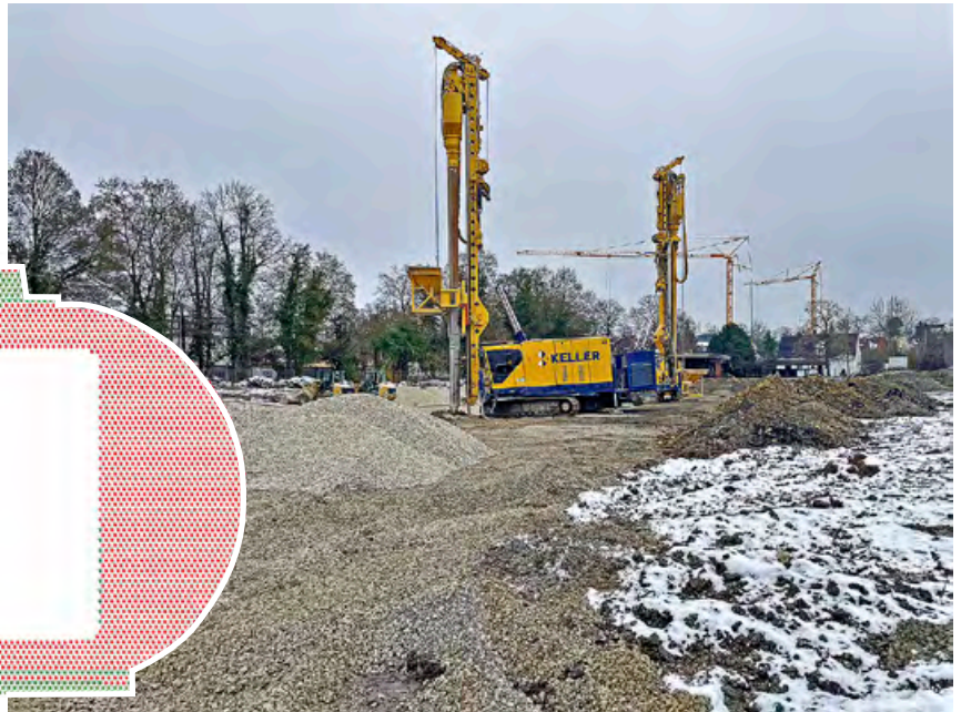
Aufwändige Bodenstabilisierung im Spezialtiefbau
