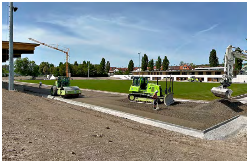
DIN-gerechter Einbau der Tragschichten für die Leichtathletikflächen
