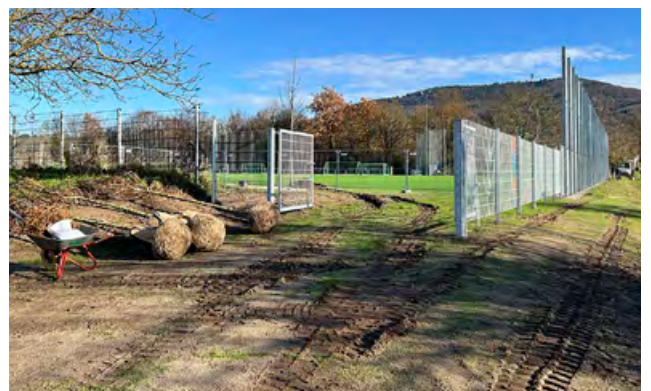
Neue bis zu 8 m hohe Ballfangzäune und Baumpflanzungen
